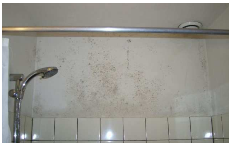
▲ douche met schimmel op koude kopgevel ondanks veel ventilatie
