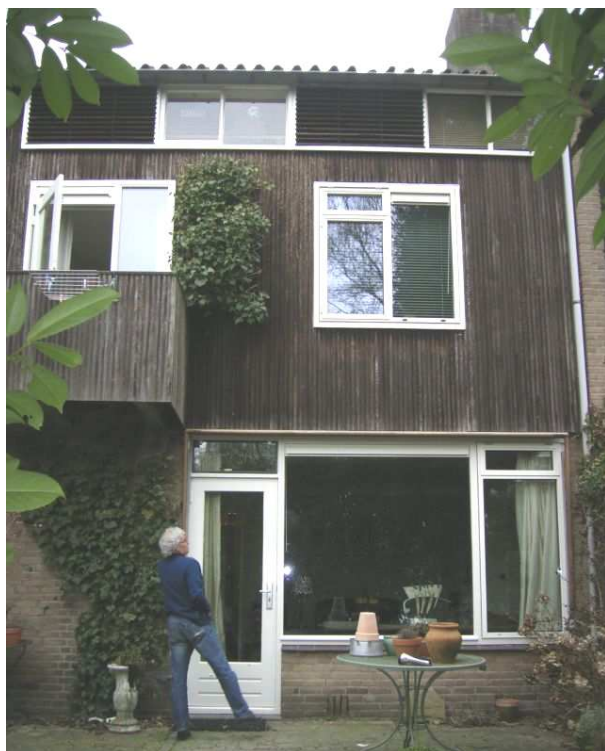
▲ achtergevel, achter hout toch een spouwmuur
