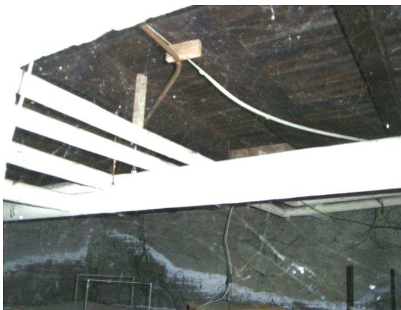
▲ kruipruimte en houten woonkamervloer in gevelvoetsporen
