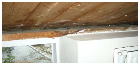
▲ douche met schimmel op koude kopgevel ondanks veel ventilatie
